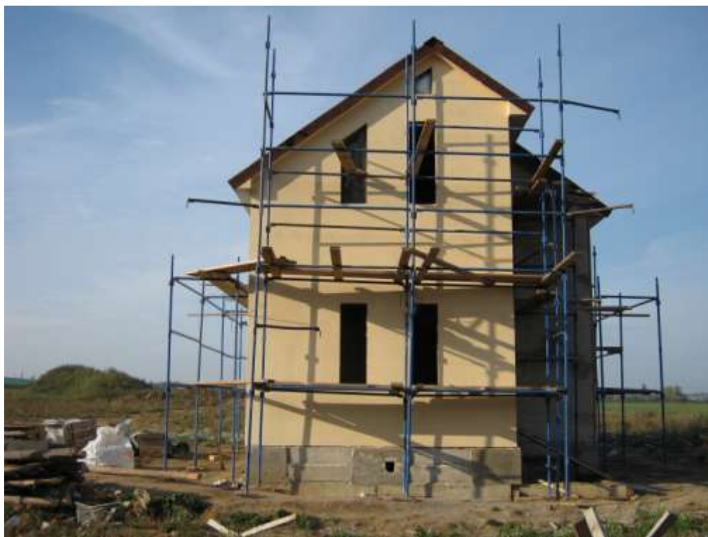
Рис.2.34 Стена без швов на основе плит GREEN BOARD® GB-600 с нанесённой на неё эластичной штукатуркой
