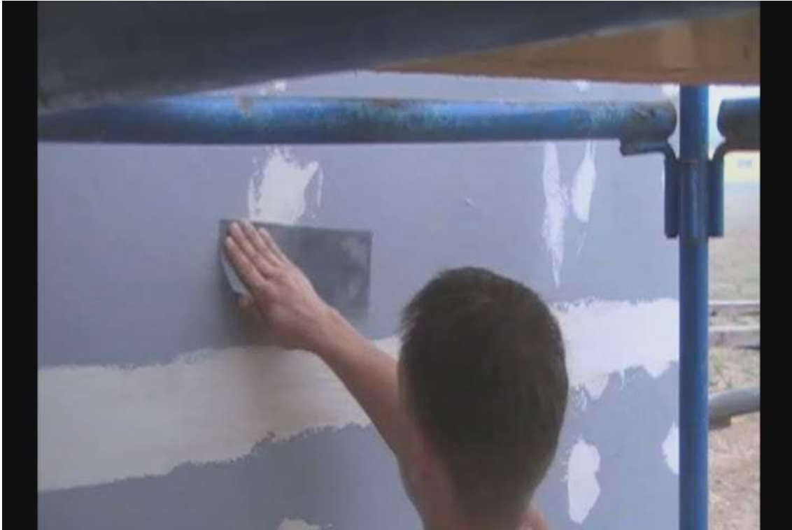
Рис.2.28 Шпатлёвка мест соединений плит и мест крепления саморезов к стойкам каркаса
