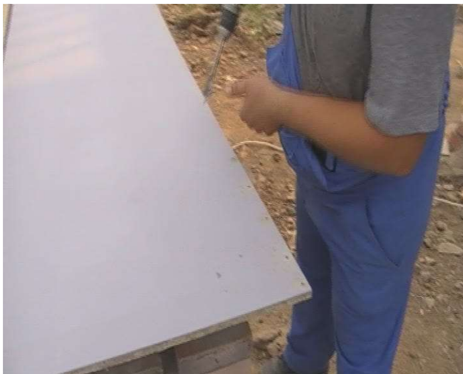
Рис.2.69 Разметка плиты под установку шурупов через 100 мм
