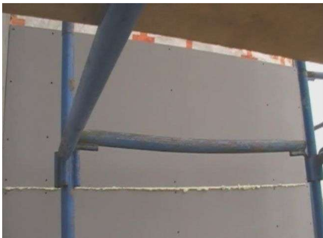
Рис.2.40 Установка плит GB-600F вплотную. Пена должна выступать из шва по всей длине.
