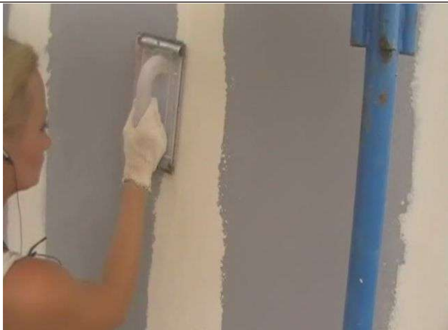
Рис.2.83 Выравнивание стыка плит шпаклёвкой для наружных работ
