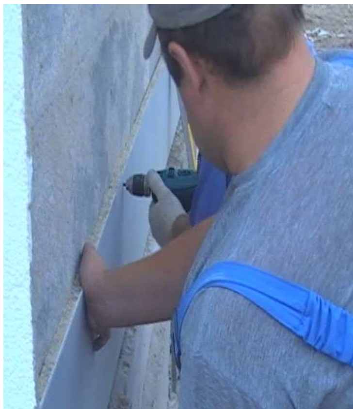
Рис.2.56 Крепление плиты GB450 при помощи саморезов после приклеивания на существующую обшивку здания
