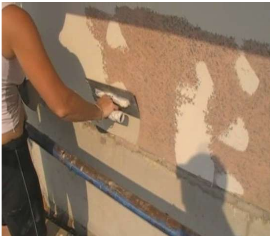
Рис.2.122 Нанесение выравнивающего слоя шпатлёвки для наружных работ на всю плоскость стены
