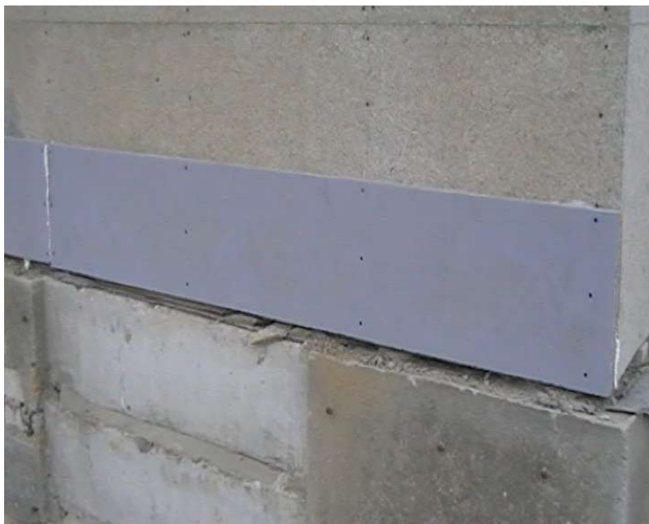
Рис.2.26 Нижняя установленная плита. Общий вид
