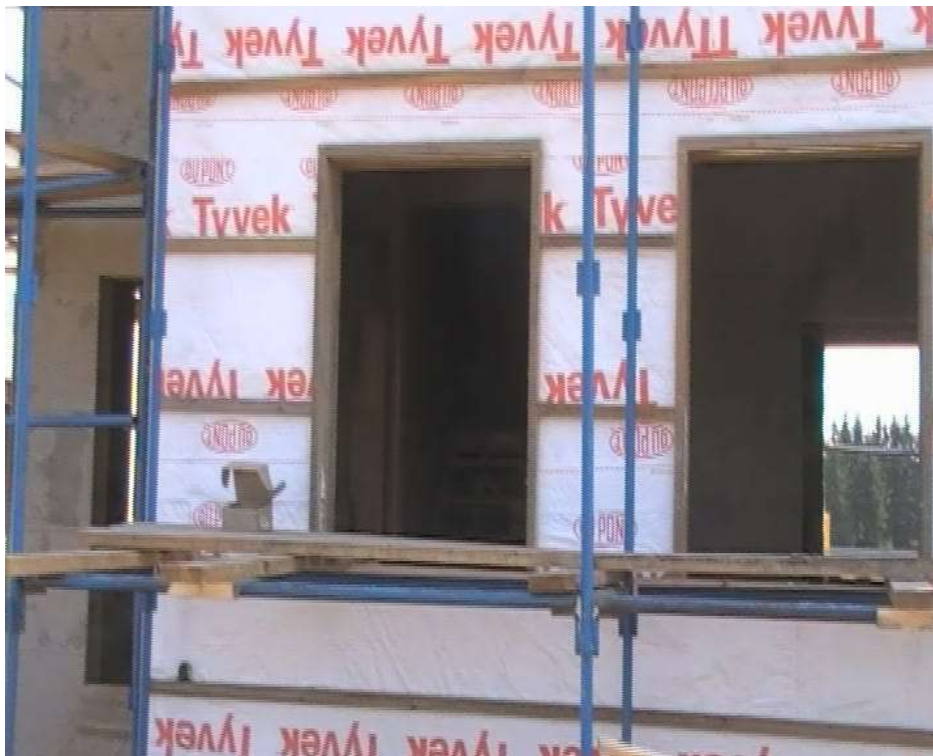
Рис.2.115 Общий вид обрешетки на фасаде
