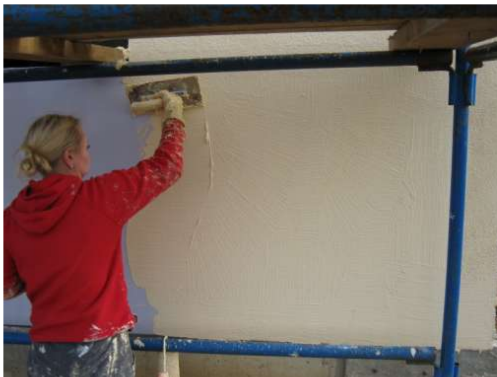
Рис.2.86 Нанесение эластичной шпатлёвки
