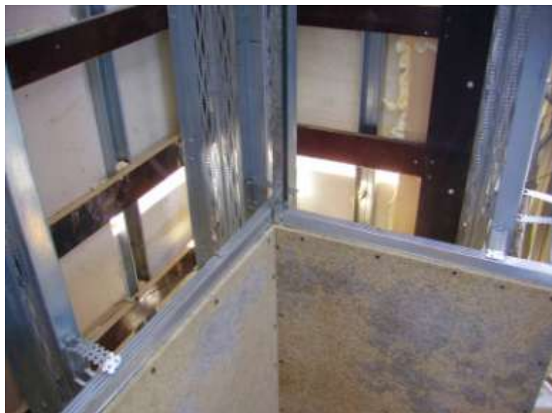
Рис.11.13 Крепление плит Green Board® к стальному термопрофилю
