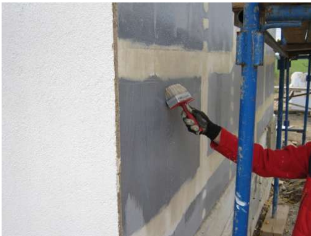
Рис.2.30 Покрытие стены грунтовкой "Бетоноконттакт"
