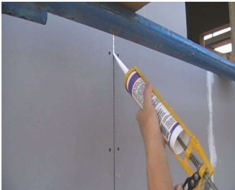
Рис.2.113 Заполнение стыка между плитами
