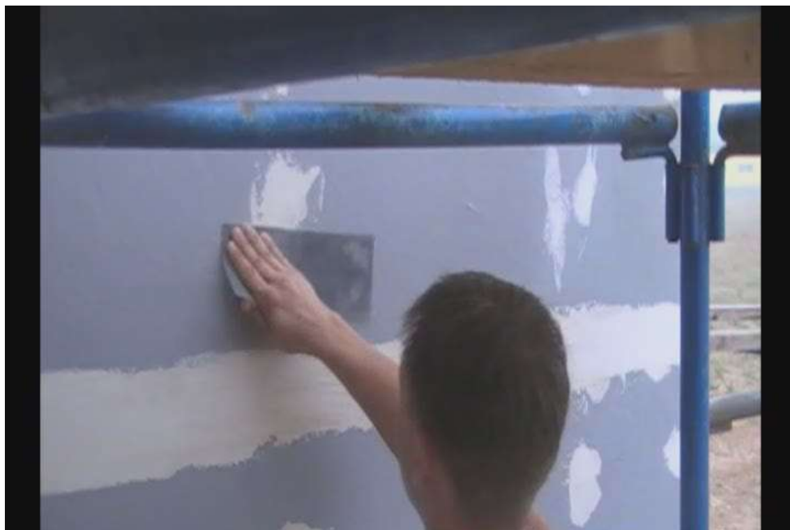
Рис.2.42 Шпатлёвка мест соединений плит и мест крепления саморезов к стойкам каркаса
