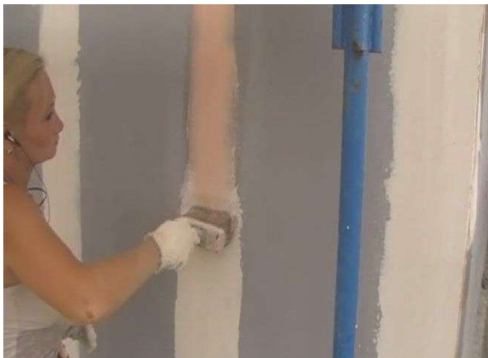
Рис.2.84 Покрытие стыка плит шпатлёвкой "Бетоноконттакт"
