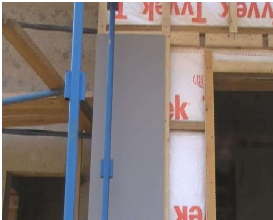
Рис.2.79 Установка плит GB-3F со швами
