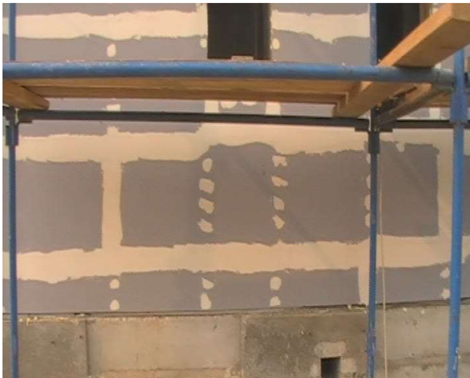
Рис.2.29 Стена с зашпатлёванными местами соединений плит и мест крепления саморезов к стойкам каркаса
