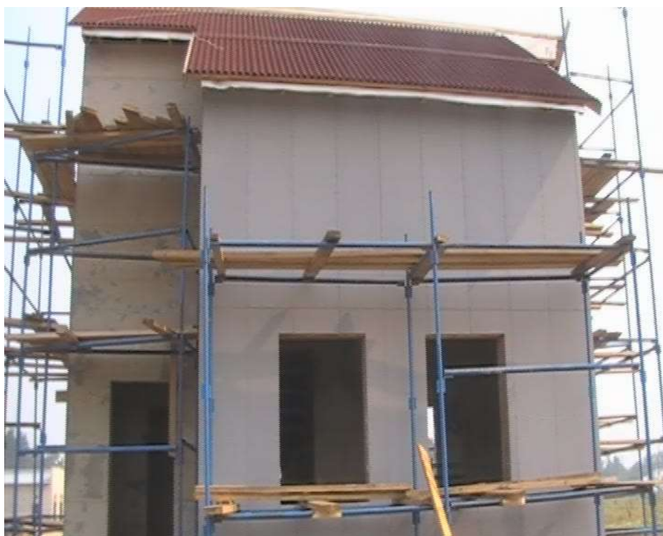
Рис.2.79 Установка плит GB-3F со швами
