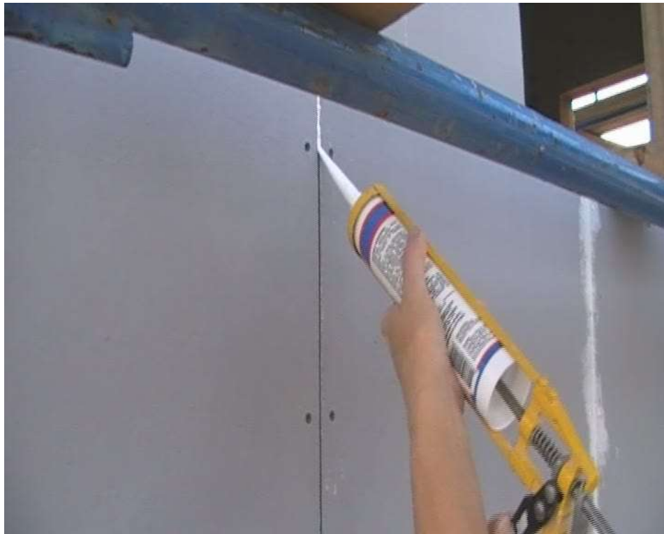
Рис.2.81 Заполнение шва силиконовым или акриловым герметиком
