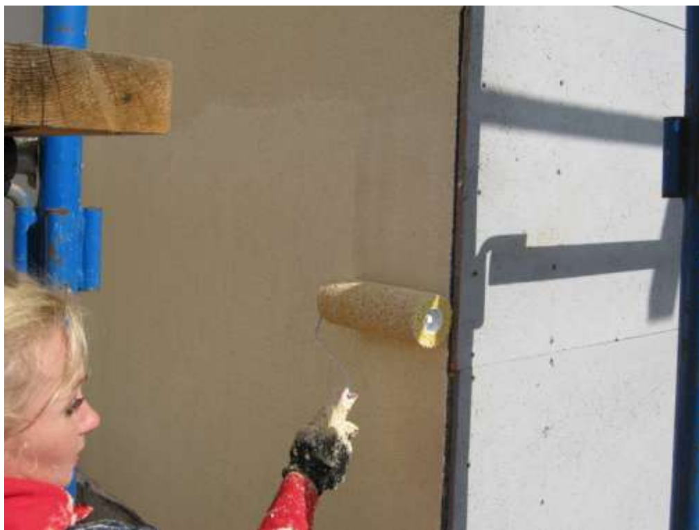
Рис.2.47 Нанесение на стену эластичной штукатурки
