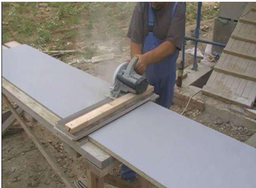
Рис.2.35 Резка плит GB-1F на месте строительства под размер – циркулярная пила, диск с твердосплавными напайками
