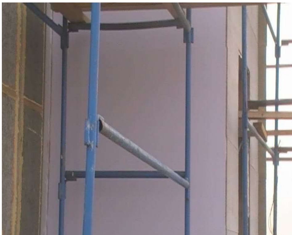
Рис.2.44 Стена после покраски водоэмульсионной краской
