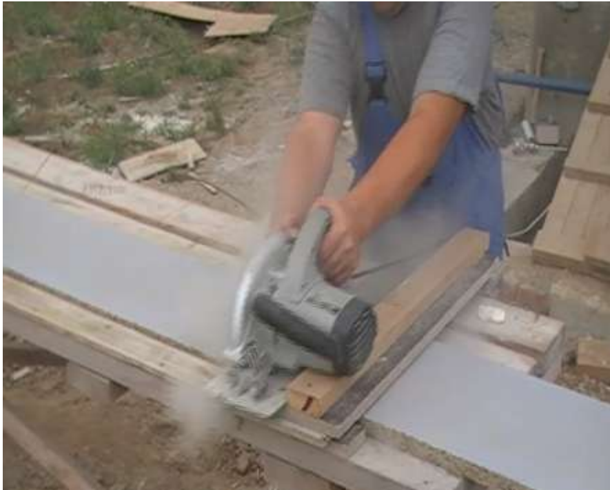
Рис.2.22 Нарезка нижней плиты шириной 300 мм. (Необходимость возникла из-за того, что подшивка из плит GB3-12 была произведена горизонтально).
