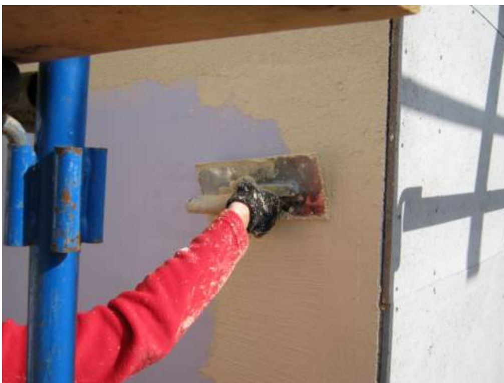
Рис.2.46 Нанесение на стену эластичной штукатурки
