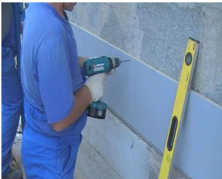
Рис.2.25 Крепление нижней приклеиваемой плиты к стойкам каркаса
