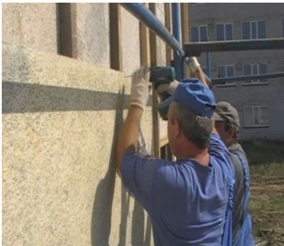
Рис.2.119 Крепление плиты GB2 (средней плотности) саморезами
