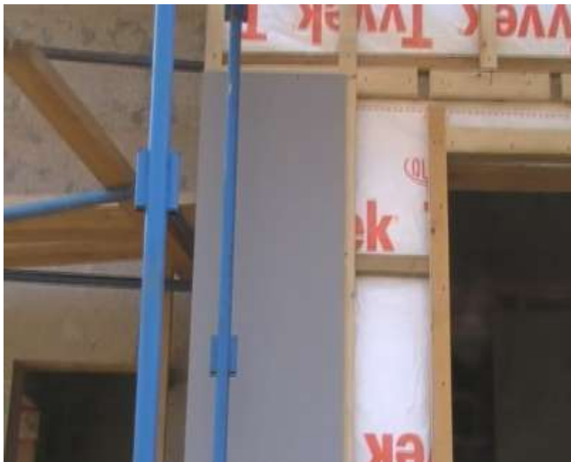
Рис.2.112 Монтаж плиты GB3 на обрешетку
