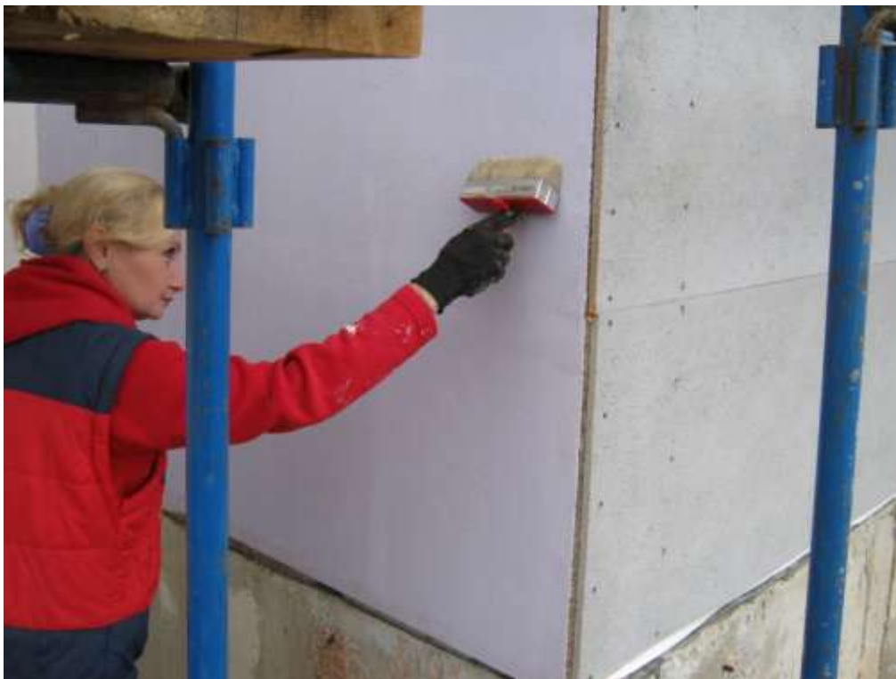
Рис.2.45 Нанесение на стену грунтовки по рекомендации производителя эластичной штукатурки
