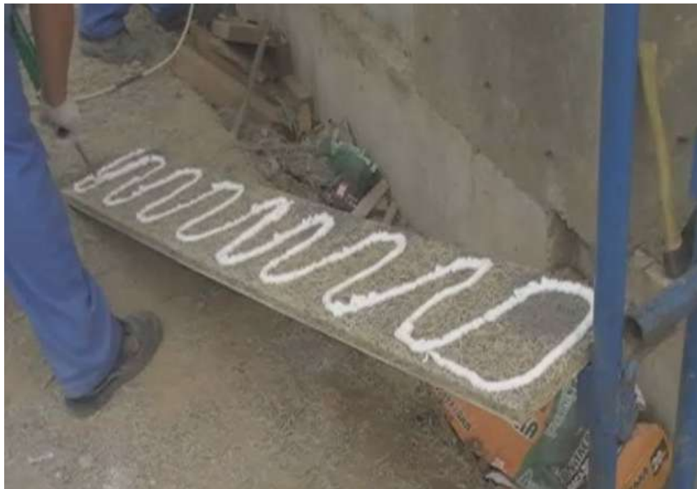
Рис.2.23 Нанесение монтажной пены на приклеиваемую плиту GB-600
