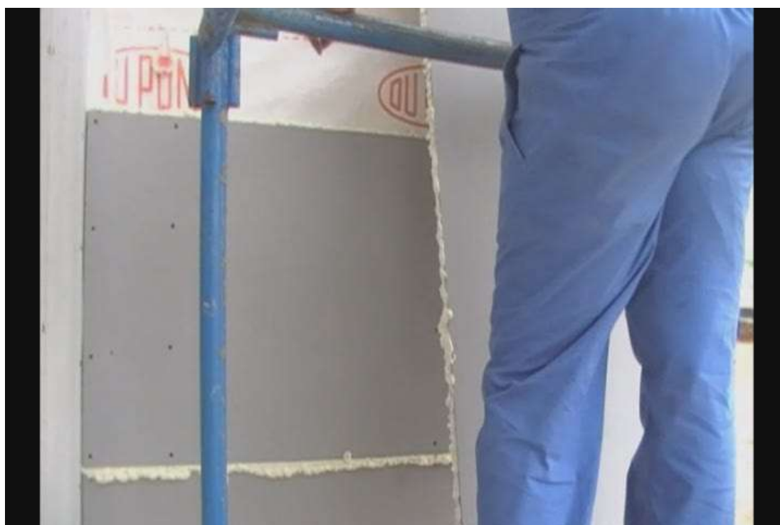
Рис.2.38 Нанесение пены на торец плиты, подготовленной к установке. Пена должна немного впитаться.
