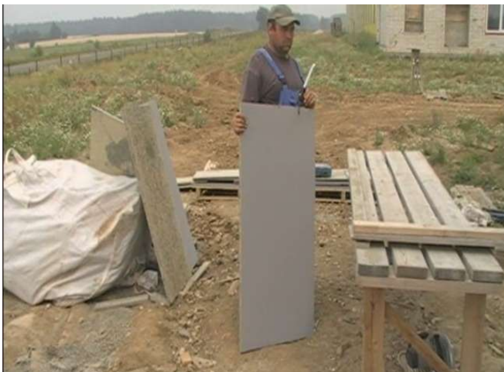
Рис. 2.36 Плита обрезана в размер перед монтажом на наружную стену дома
