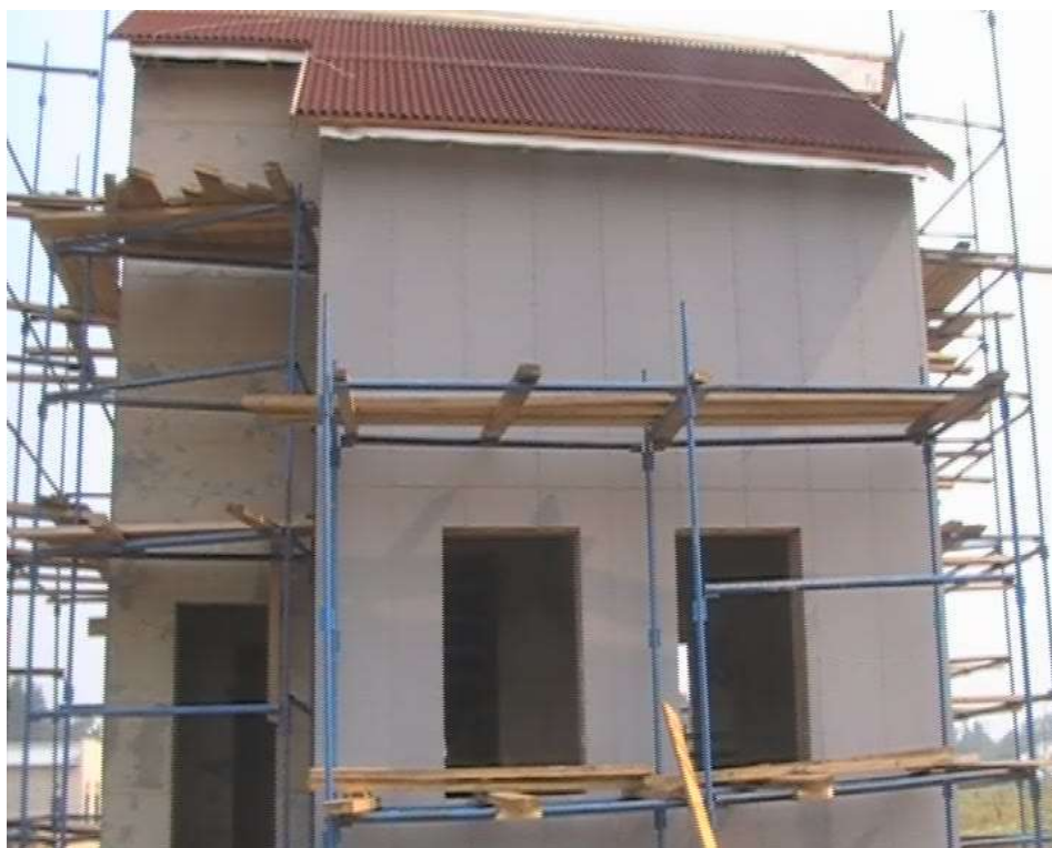
Рис.2.114 Общий вид смонтированного вентфасада
