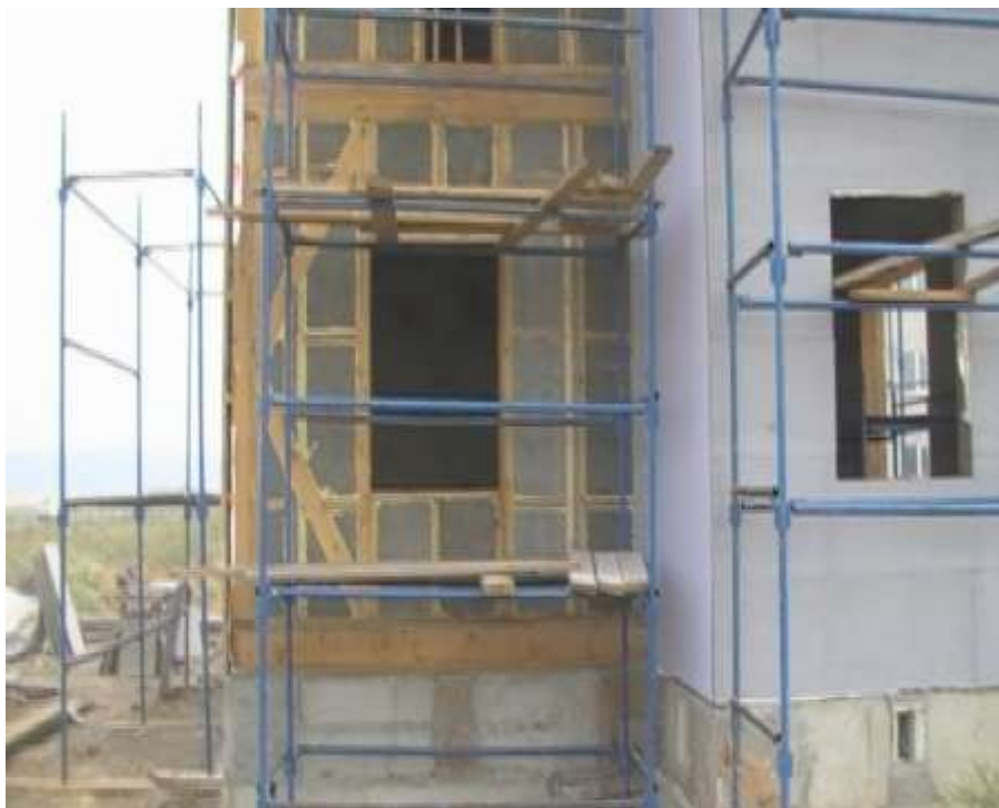
Рис.2.67 Вид стены перед монтажом на существующий каркас плит GB-3F
