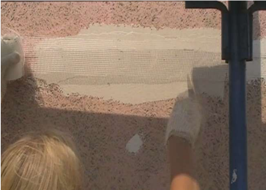
Рис.2.121 Армирование шва между плитами GB-2 сеткой стеклотканевой. Сетка вдавливается в слой фасадной шпатлевки.
