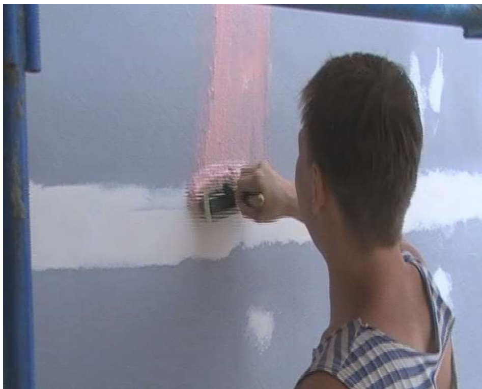
Рис.2.43 Обработка швов грунтом «Бетоноконттакт» под покраску водоэмульсионной краской
