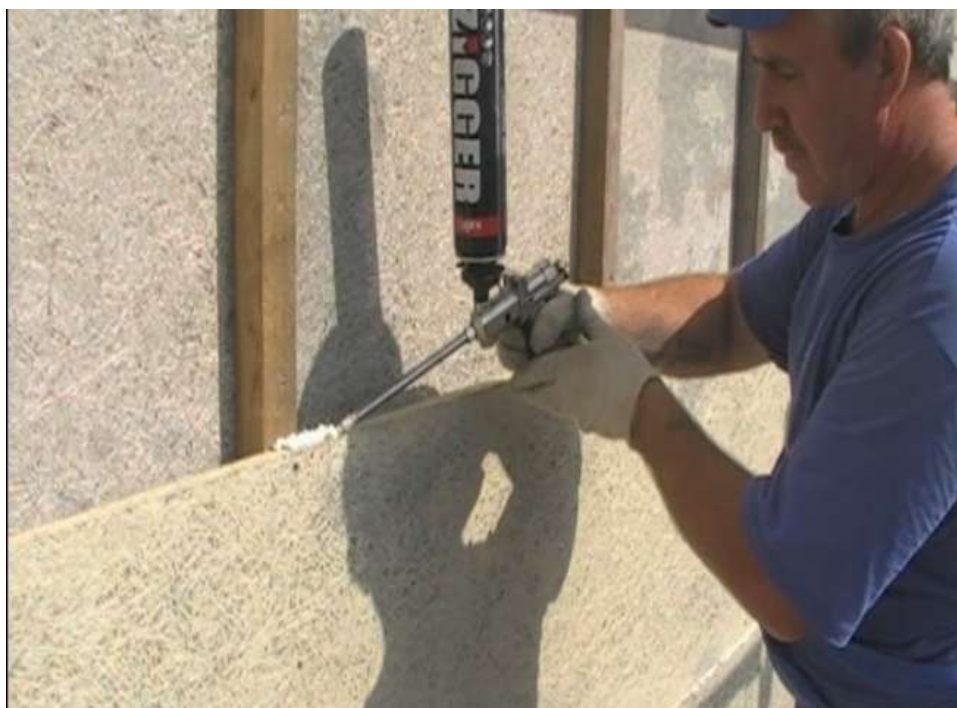
Рис.2.117 Нанесение монтажной пены на торец плиты GB2 (средней плотности)
