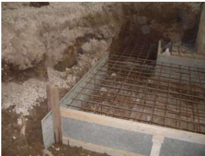
Рис.8.3 Применение системы плит Green Board® в качестве несъёмной опалубки фундамента в производственном цехе ООО «Строительные Инновации»
