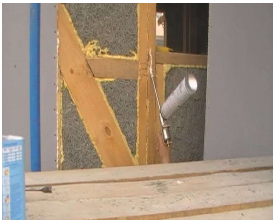
Рис.2.72 Нанесение пены на деревянный каркас перед установкой плиты
