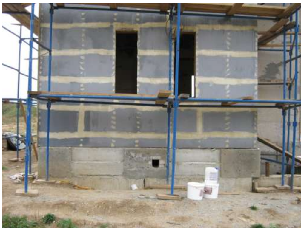
Рис.2.31 Стена, покрытая грунтовкой "Бетоноконттакт"
