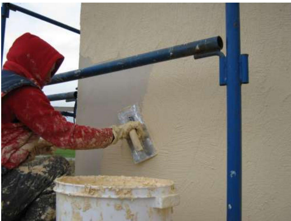
Рис.2.123 Нанесение эластичной штукатурки на стену
