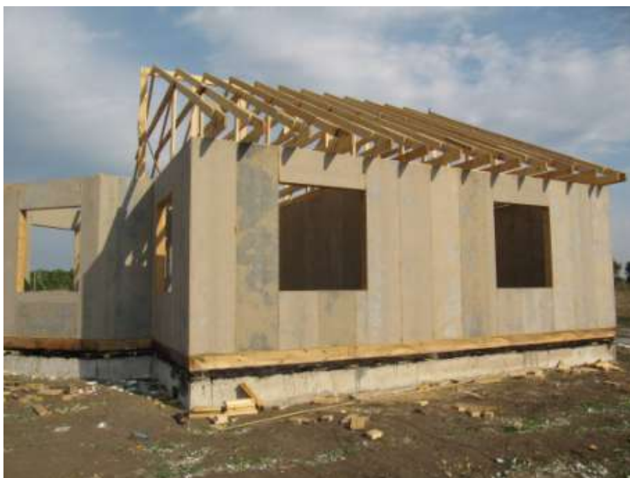
Рис.9.12 Стройка дома по SIP технологии с применением системы плит Green Board®
