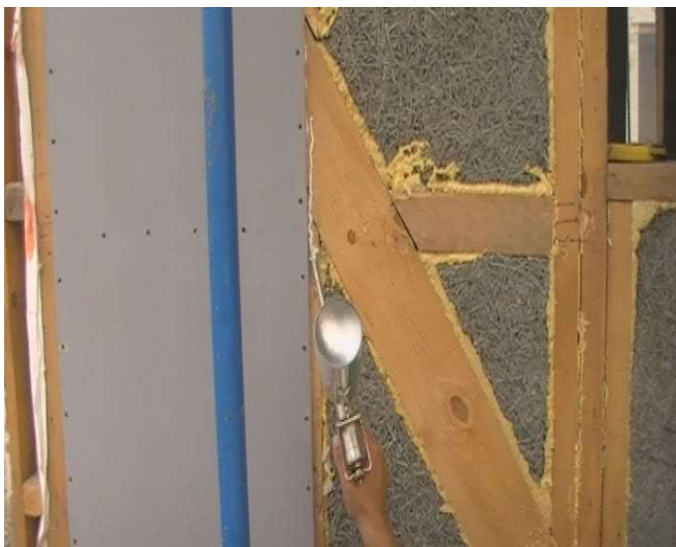
Рис.2.70 Установка плиты GB-3F на каркас. Наносится монтажная пена на торец плиты.
