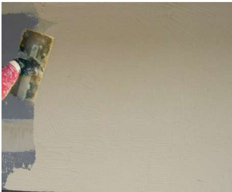
Рис.2.32 Нанесение эластичной штукатурки на стену
