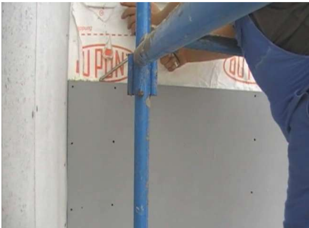
Рис.2.37 Нанесение пены на торец ранее смонтированной плиты. Пена должна немного впитаться.
