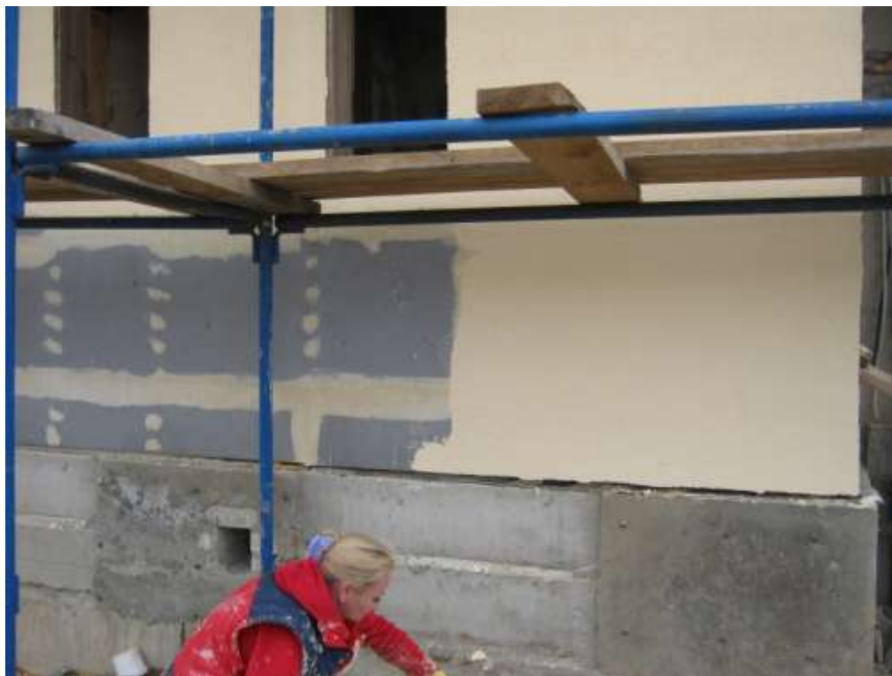
Рис.2.33 Процесс нанесения эластичной штукатурки на стену без швов на основе плит GREEN BOARD® GB-600
