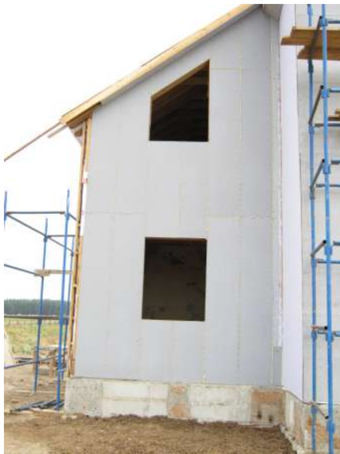
Рис.2.73 Стена, облицованная установленными без зазоров плитами GB3F-12
