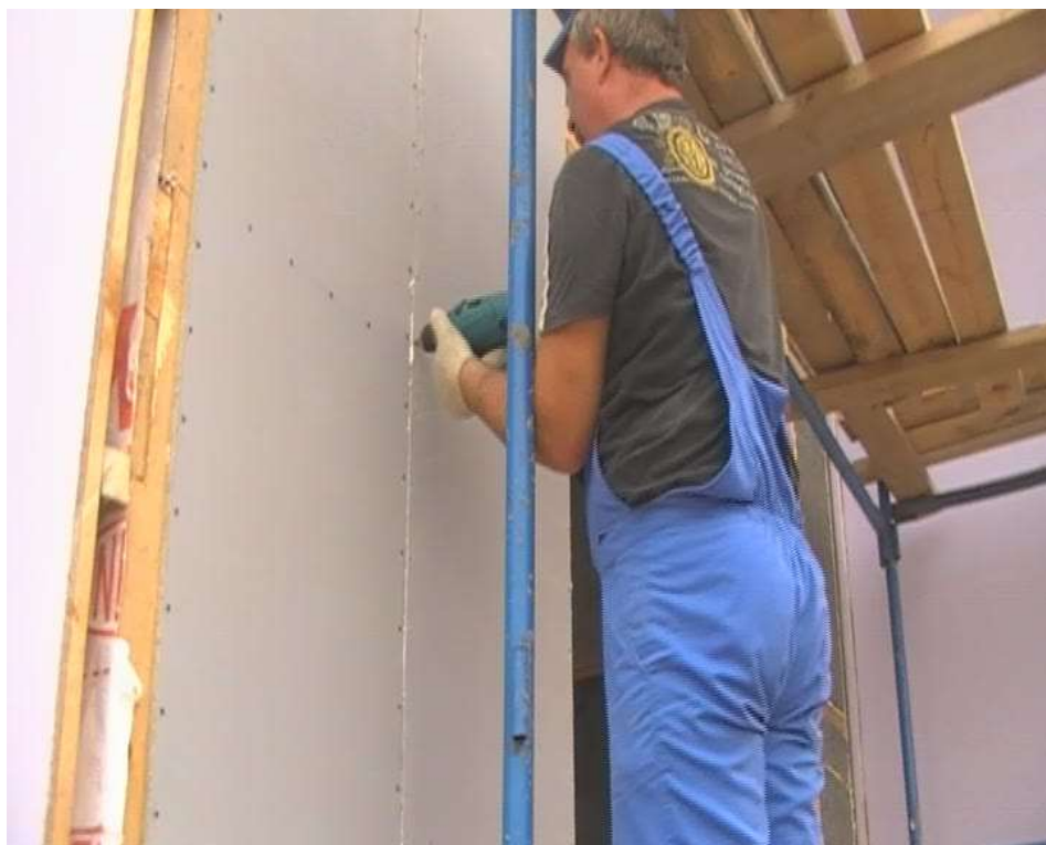
Рис.2.71 Крепление плиты к деревянному каркасу
