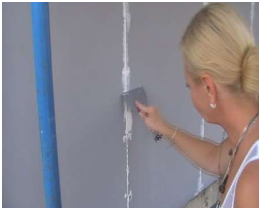
Рис.2.81 Заполнение шва силиконовым или акриловым герметиком
