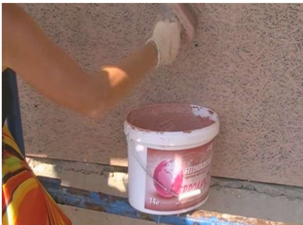
Рис.2.120 Покрытие поверхности плит GB-2 грунтовкой "Бетониконттакт"
