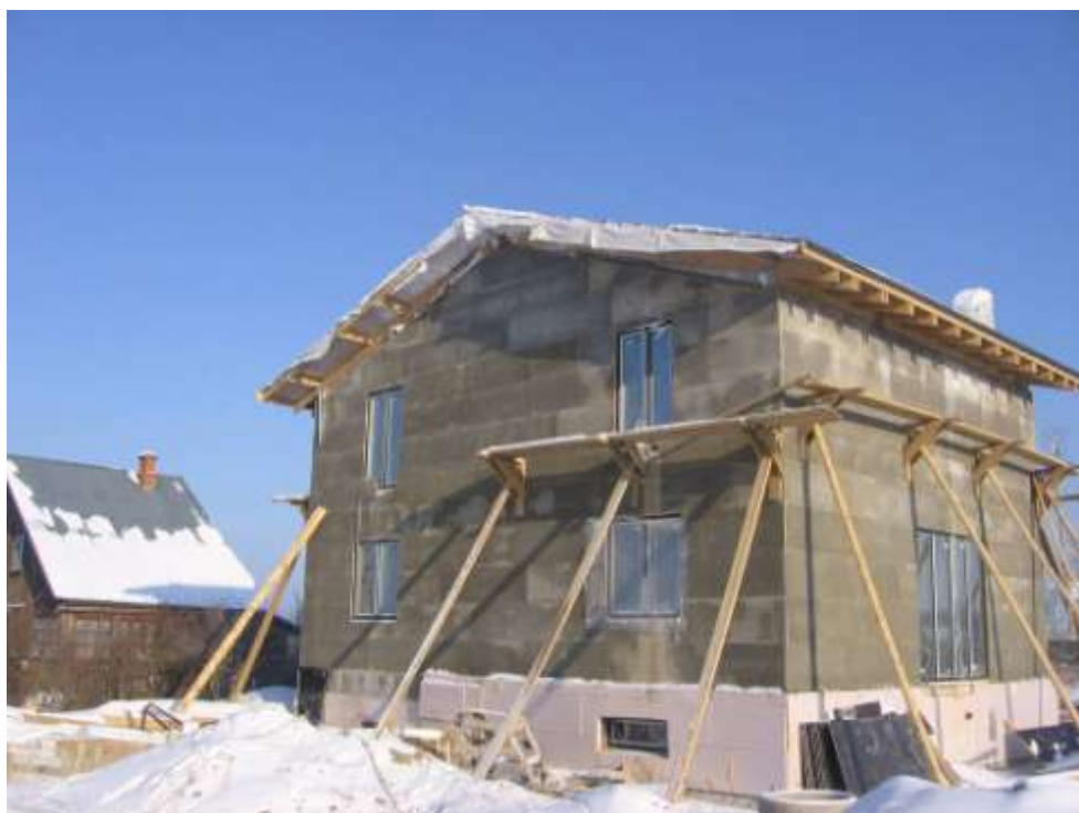
Рис.8.16 Строительство монолитного дома с применением несъёмной опалубки из плит GREEN BOARD®
