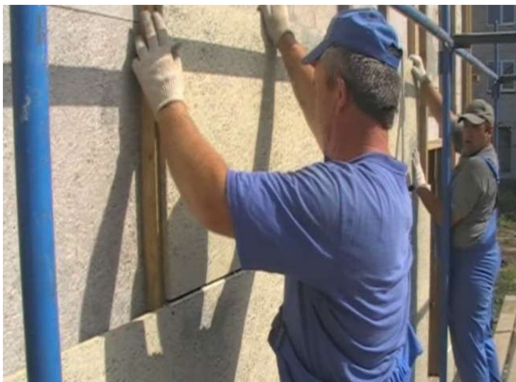
Рис.2.118 Монтаж плиты GB2 (средней плотности)
