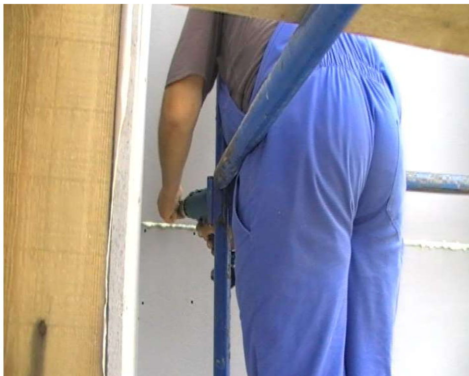
Рис.2.41 Крепление плиты GB-600F к деревянным стойкам на саморезы
