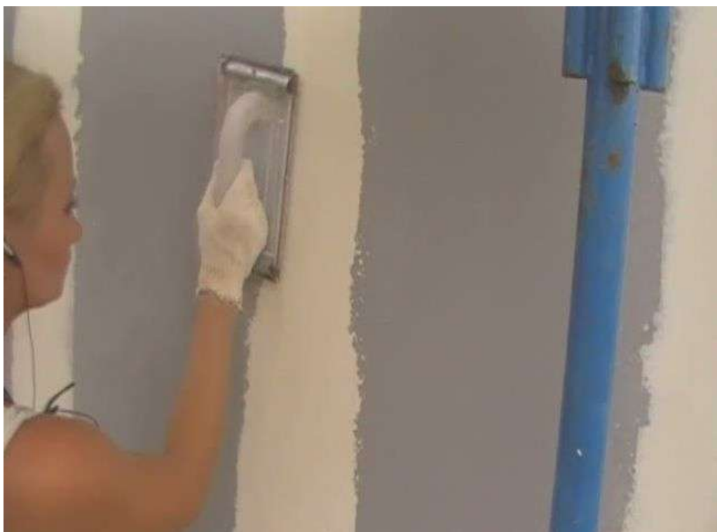
Рис.2.74 Нанесение шпатлевки на места соединения (стык) плит между собой
