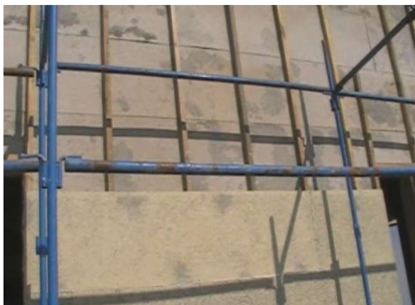
Рис.2.116 Начало монтажа плит GB2 (средней плотности) на обрешетку
