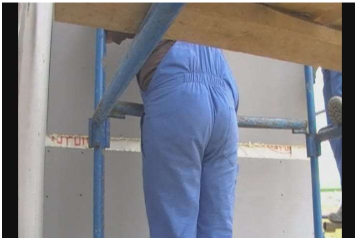
Рис.2.39 Установка плит GB-600F вплотную. Пена должна выступать из шва по всей длине.
