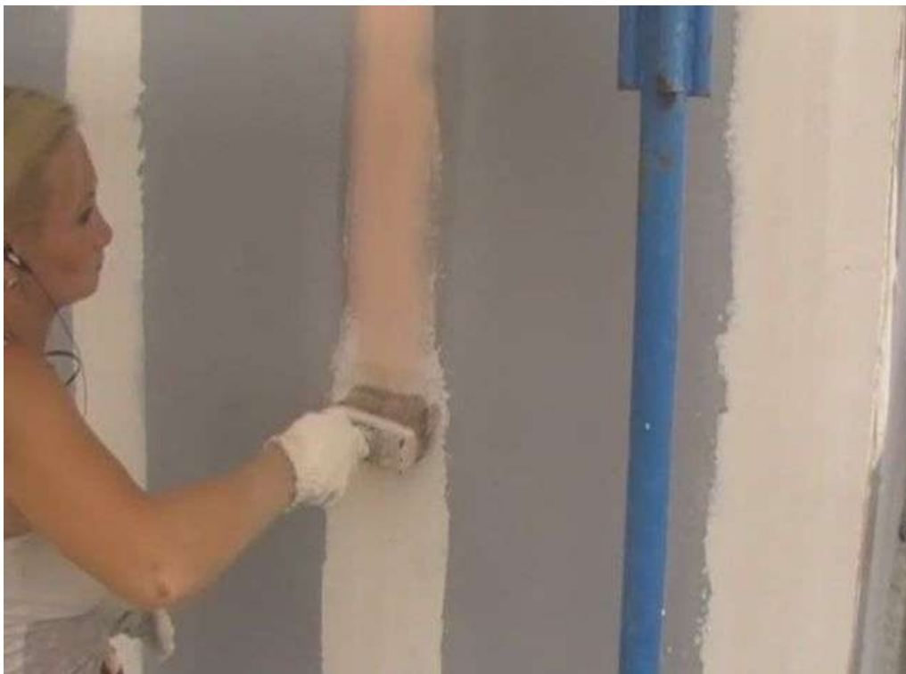
Рис.2.75 Нанесение грунта «Бетоноконтакт» на зашпатлеванные швы перед нанесением декоративной шпаклёвки
