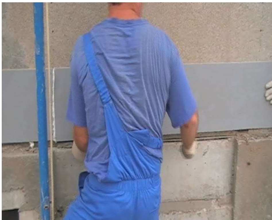
Рис.2.24 Установка нижней приклеиваемой плиты
